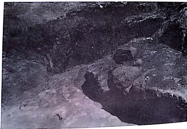
Fig. 5.—Zanja de protección para recoger las aguas que bajaban del cerro.
