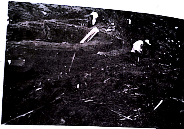
Fig. 4.—Zanja de escurrimiento de las aguas de lluvia.
